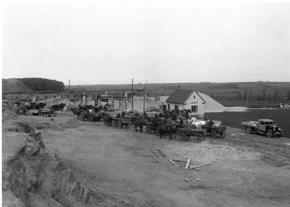
Utlastning av makadam med ca 15 hästskjutsar och två lastbilar. Bilden är från början på 1920-talet och från krossen i Hardeberga. Bild från Dalby saknas.
